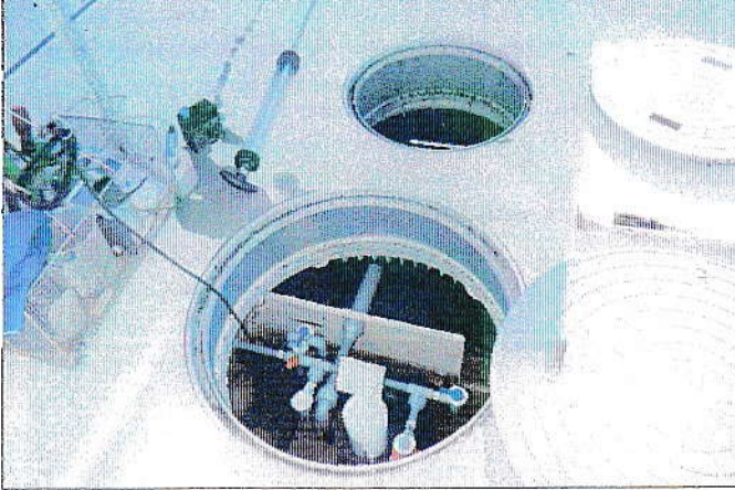
写真1 浄化槽の上部の状況
